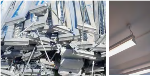
LED-Umstellung Guttenberghaus, Projektleitung und Foto: Daniel Stamminger
